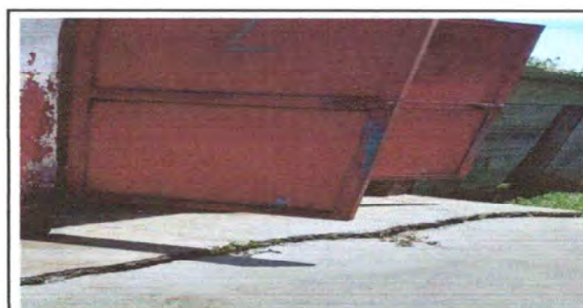
Foto 6: reparacion de puertas de metal de sanitarios
