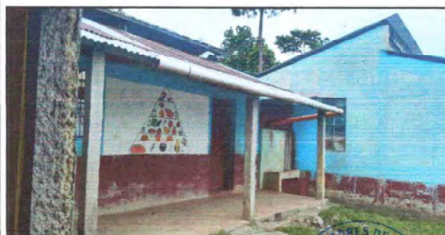
Foto 5: sustitucion de canales de agua pluviales
