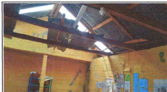
Foto 3: sustitucion de capote de madera por metal
