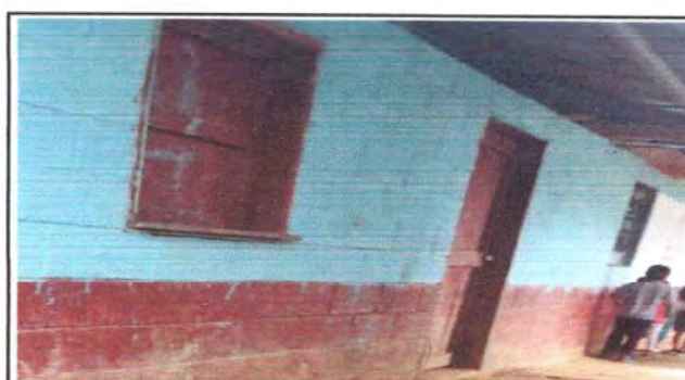
foto 10: sustitución de ventanas de madera, por metal
