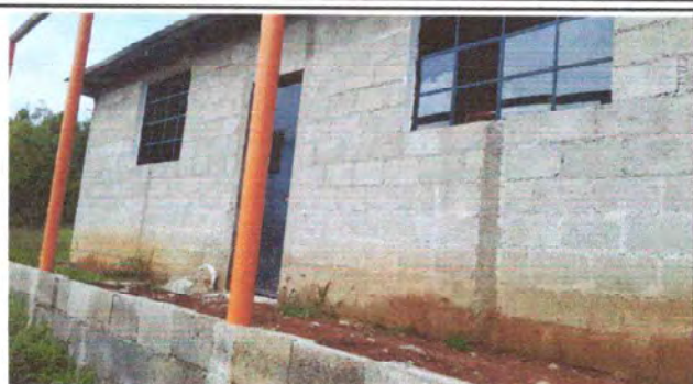
Foto 7 : repello de muros y pintura
